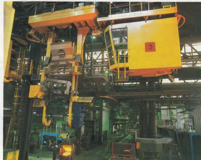
Un des trois ponts 10 tonnes, équipé d'un ensemble de levage neuf, que ce soit le treuil avec son câble renforcé, le frein de secours, le palier parachute ou le palonnier.
