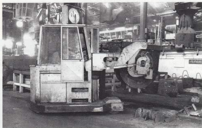
Transbordement d'une poche 3,6 tonnes dans le secteur des chemises : les tourillons sont bridés par deux paliers mobiles.
