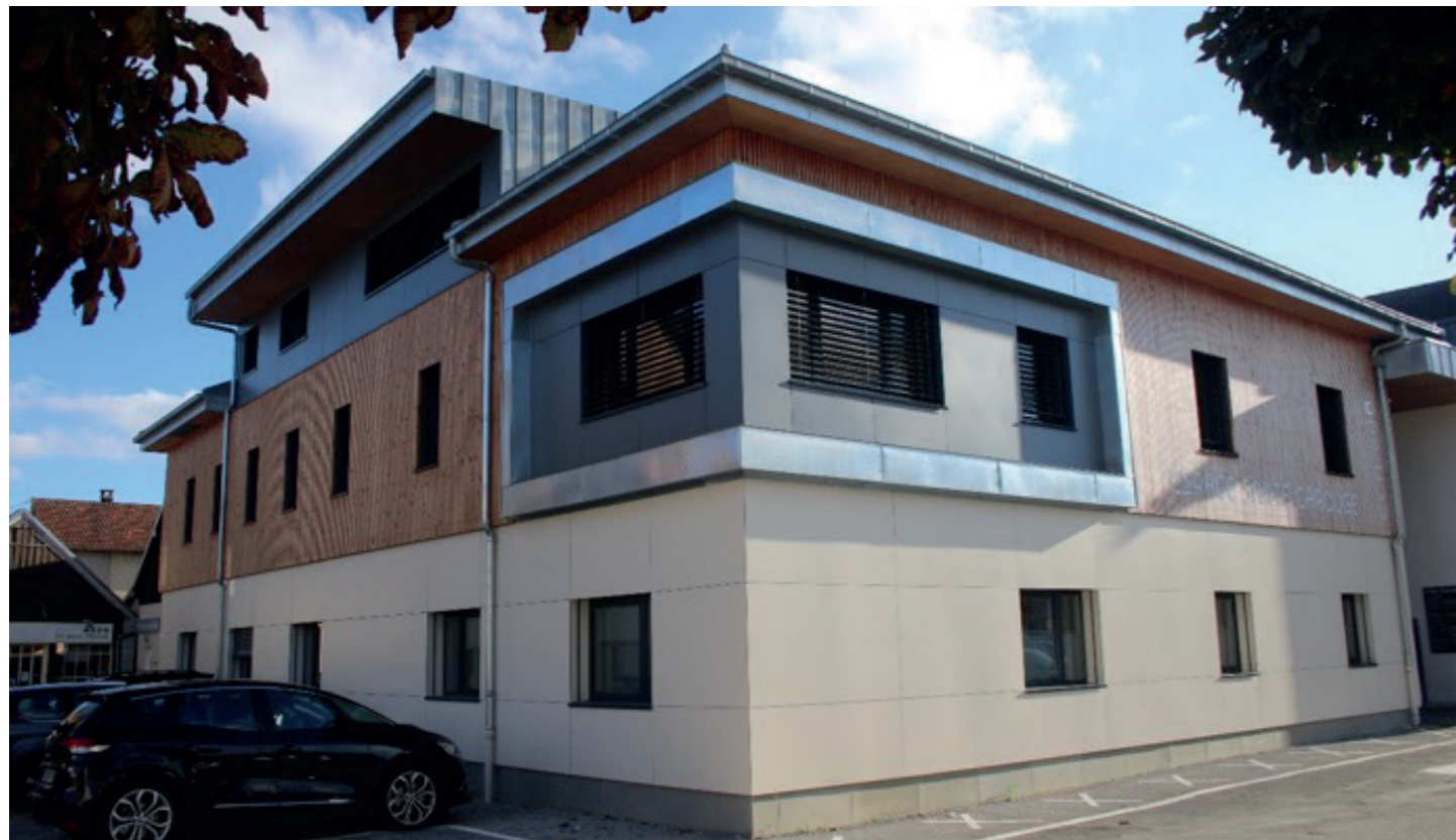
Locaux de la MSP de Noidans-le-Ferroux accueillant une microstructure (Haute-Saône)
