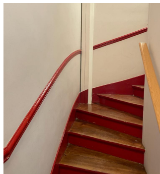
Go up to the first floor/ Monter au premier étage
