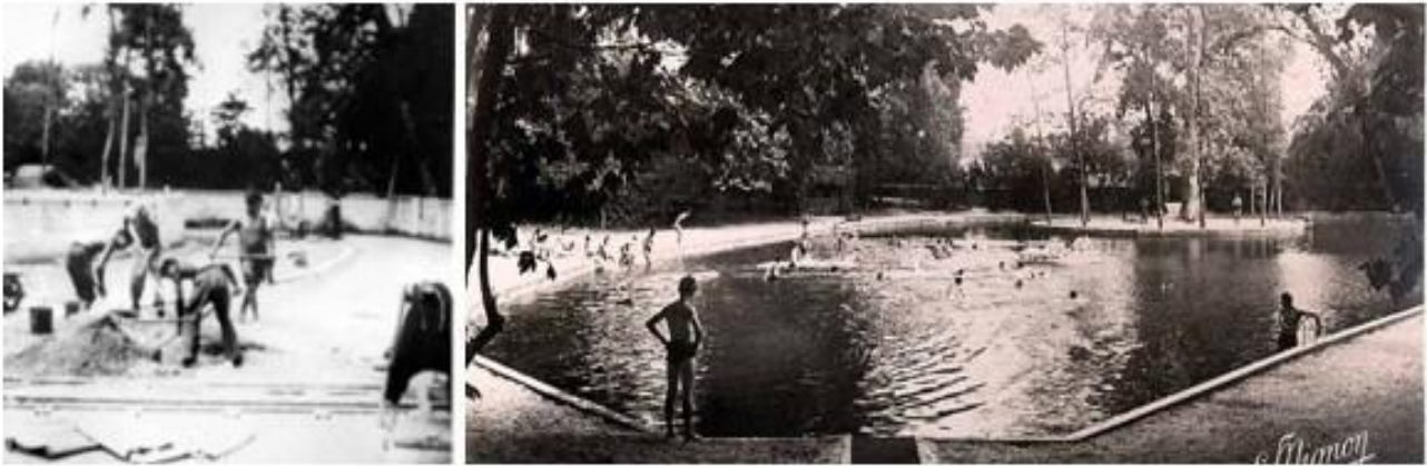
La piscine : de la construction ... à la réalisation, 1947, Fonds JC. Rouvière
