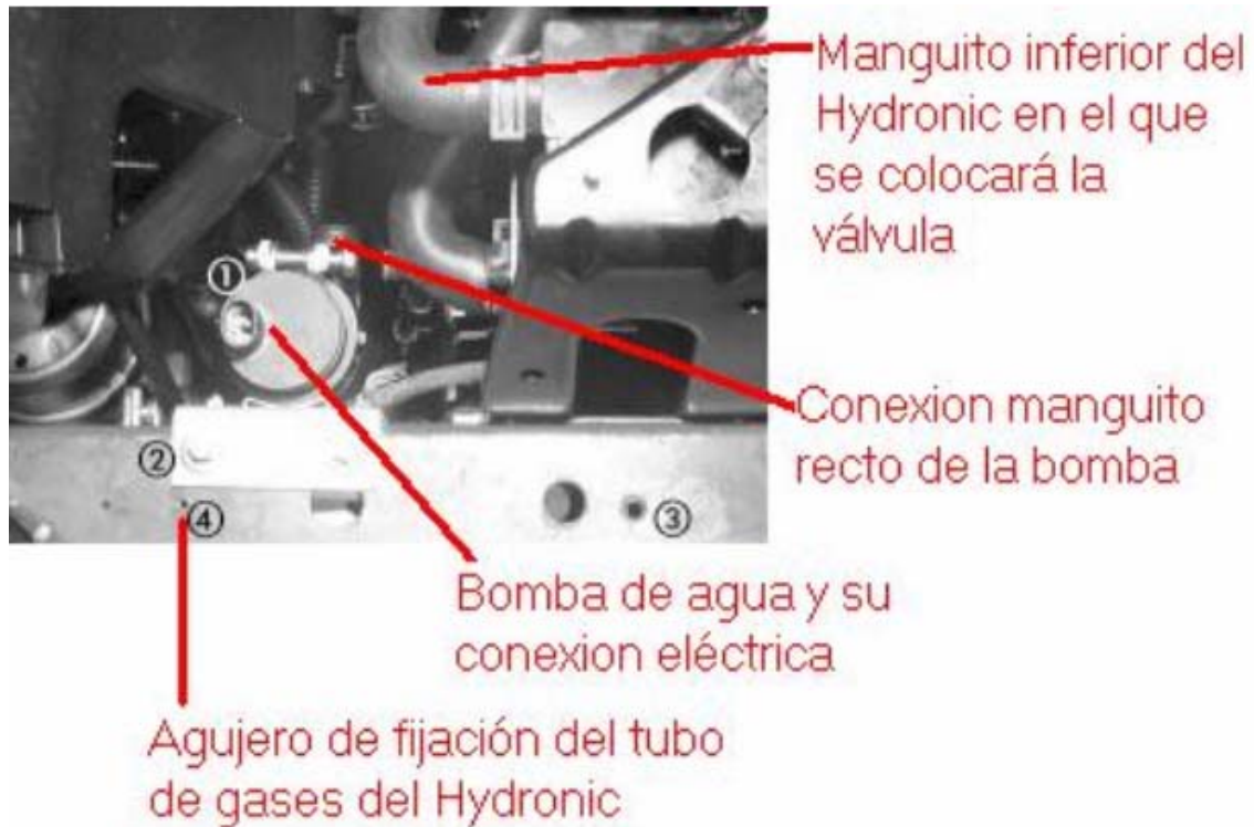
Photo 6 installation de la pompe
