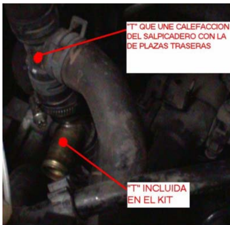
Photo 16 :T de réunion du chauffage et T du kit de montage
