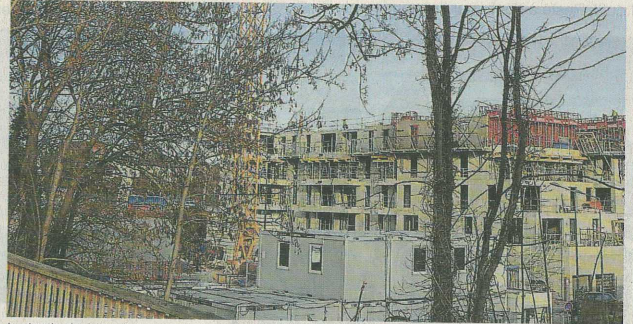
Le chantier des hauts de La Haie-Vigné a commencé depuis juillet. Les appartements devraient être livrés fin 2017.
